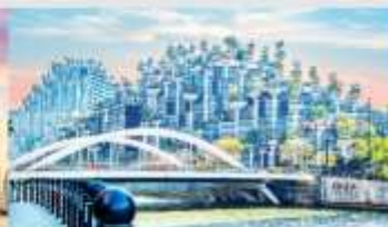
อาคารฟันทันไม
